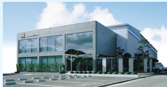
本社工場・製造事務所
